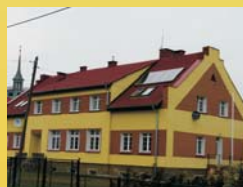
Panele solarne na kompleksie szkolnym w Wierchow
