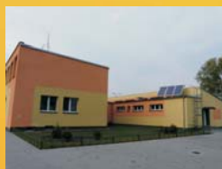
Panele solarne na Szkole w Bukowie
