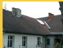
Panele solarne na Szkole w Biskupnicy
