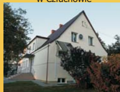
Panele solarne na zapleczu sportowym w Głędowie
