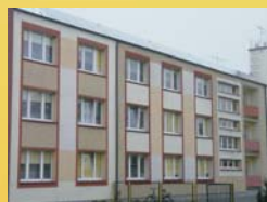
Panele solarne na Powiatowej Bursie Szkolnej w Człuchowie
